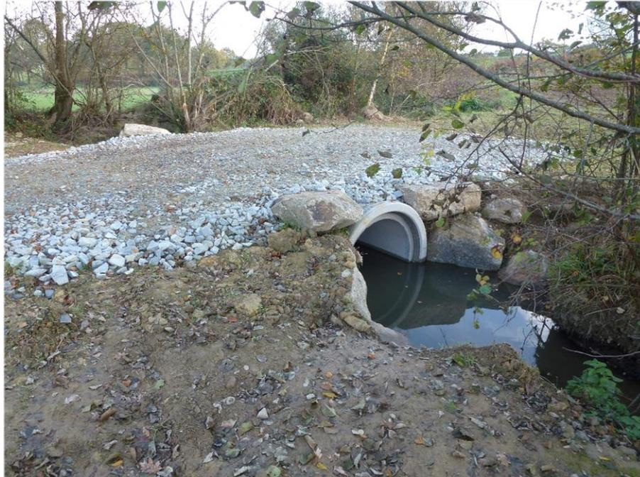
**Exemple de pose d'une buse sur un cours d'eau à la place d'un passage à gué très fréquenté entre deux parcelles cultivées**
