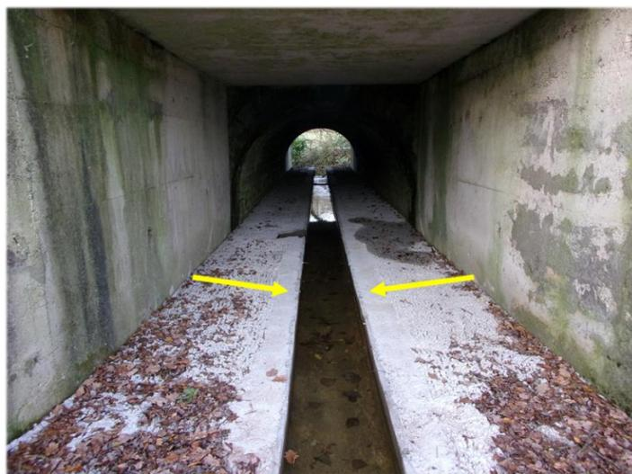
Exemple de rétrécissement de section sur un ouvrage routier (cours d'eau du Frameux)
