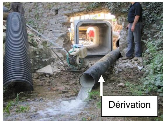
Ces travaux concernent les ouvrages que l'on souhaite remplacer par des buses en PEHD, en béton, ou d'autres types d'ouvrages (passerelles, pont-cadre, ovoïde, etc.).
