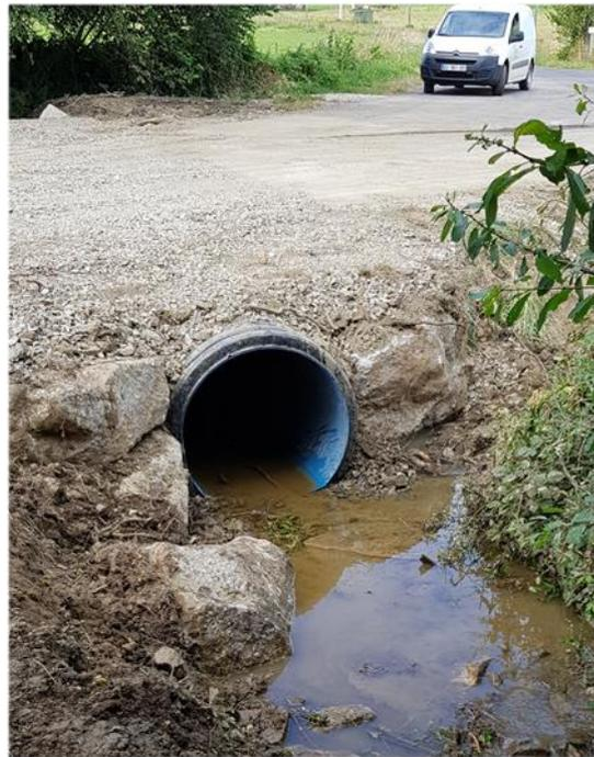
**Pose d'une buse adaptée au gabarit du lit**
