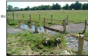
Le passage à gué peut être ainsi ouvert ou fermé aisément. Dans le cas d'un franchissement permanent, bloquer l'accès au cours d'eau par le milieu du gué.
